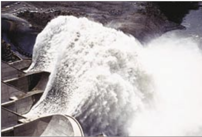
Van der Kloof Dam: chute spillways
