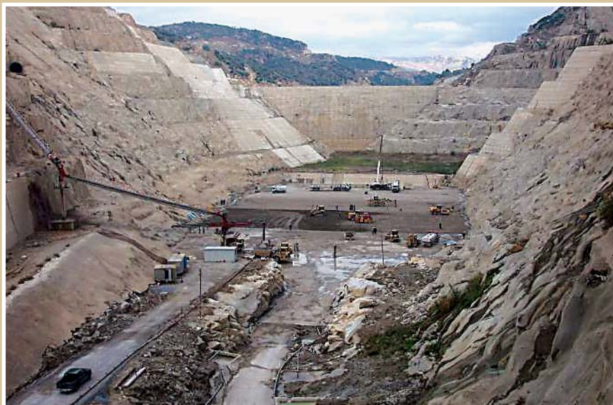
Çine dam site
