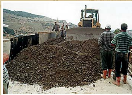
Test fill construction
